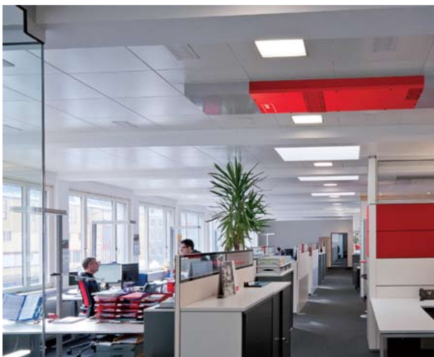
Az álmennyezetbe építés látványos: decentralizált szellőztető rendszerként a Hoval HomeVent® berendezés felújításnál is alkalmazható.
