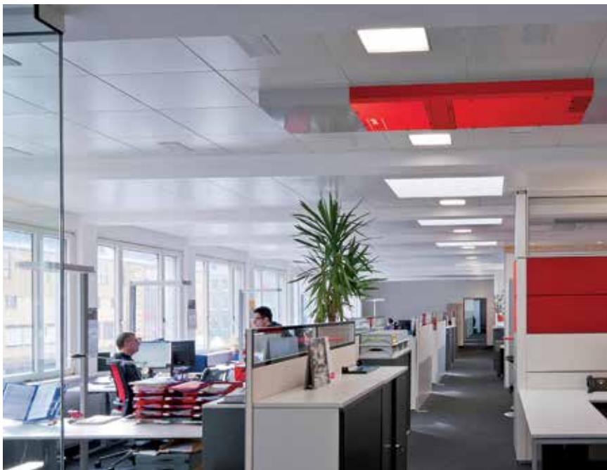
Az álmennyezetbe építés látványos: decentralizált szellőztető rendszerként a Hoval HomeVent® berendezés felújításnál is alkalmazható.
