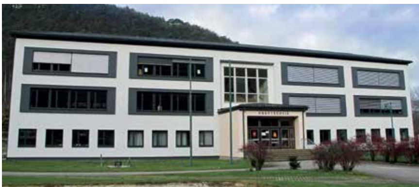
Felújításnál: HomeVent® comfort FR (500); UltraGas® kondenzációs kazán Egy iskola felújítása teljes sikerrel: az új kondenzációs kazánt ritkán használják, mert a hagyományos ablaknyitások szellőztetésre már nincs szükség. Minden osztályban a frisslevegő-ellátás egyedileg megoldott. Az utólagos telepítés "alig drágább, mint egy új épületnél."
